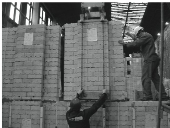
Het plaatsen van een muur in een anode bakoven
