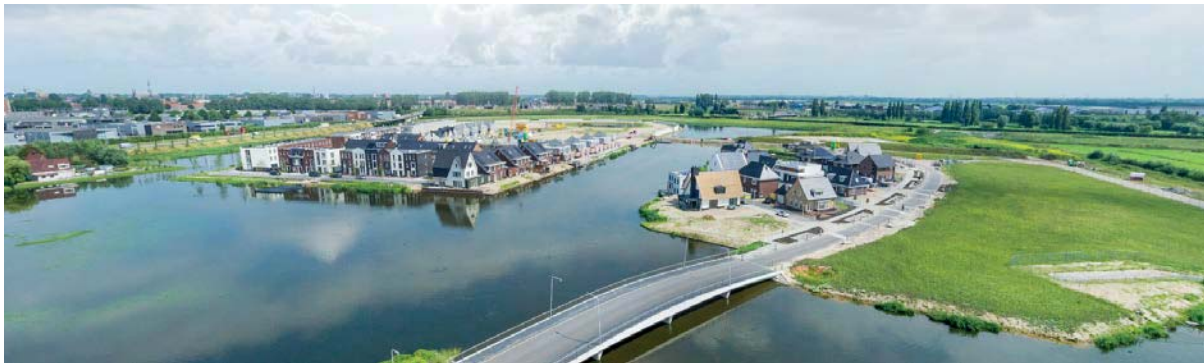
Afbeelding 22. De locatie van de woningen is op het groene veld rechts van de al gebouwde vrijstaande en twee-onder-een-kap woningen
