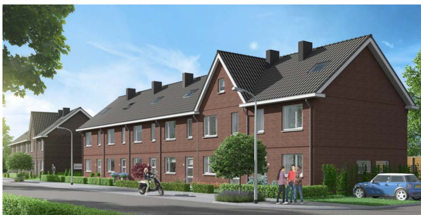
6 Modulaire gebouwde woningen
