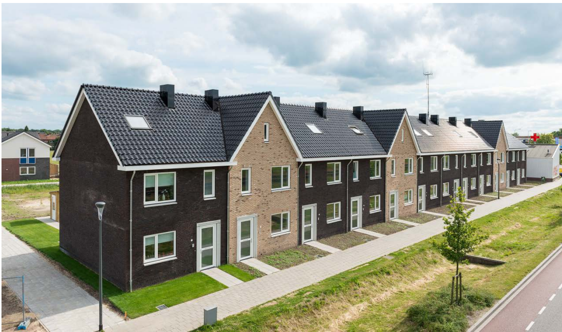
2 Modulair gebouwde nul-op-de-meter woningen
