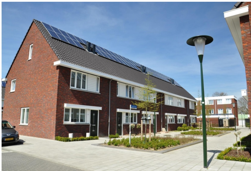
10 Modulaire gebouwe EPC-nul woningen in Eindhoven
