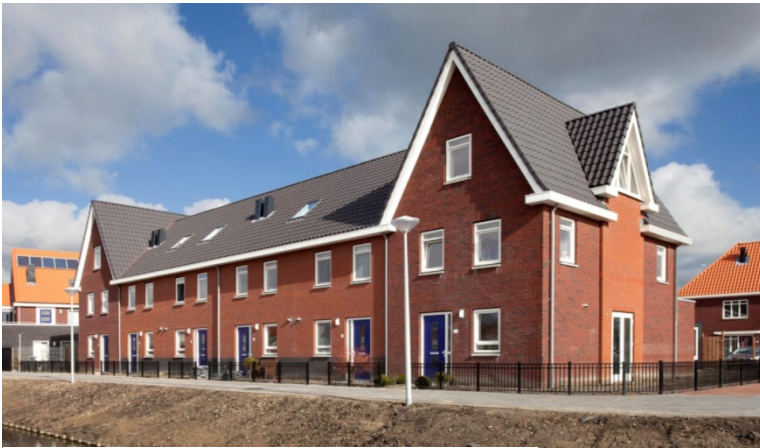
4 Modulair gebouwde nul-op-de-meter woningen
