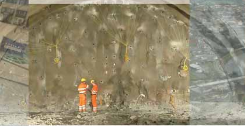
Aanleg van circa drie kilometer lange Grouftunnel, onderdeel van Route du Nord; het grootste bouwproject van Luxemburg.
