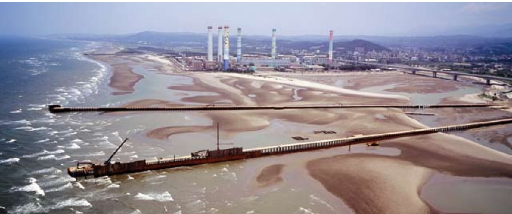
Voor de aanleg van een gaspijpleiding 130 km voor de westkust van Taiwan baggerde Boskalis de sleuven in de zeebodem, construeerde de vier kustaanlandingen en voorzag de pijpleiding van een bescherming met zand en steen.
