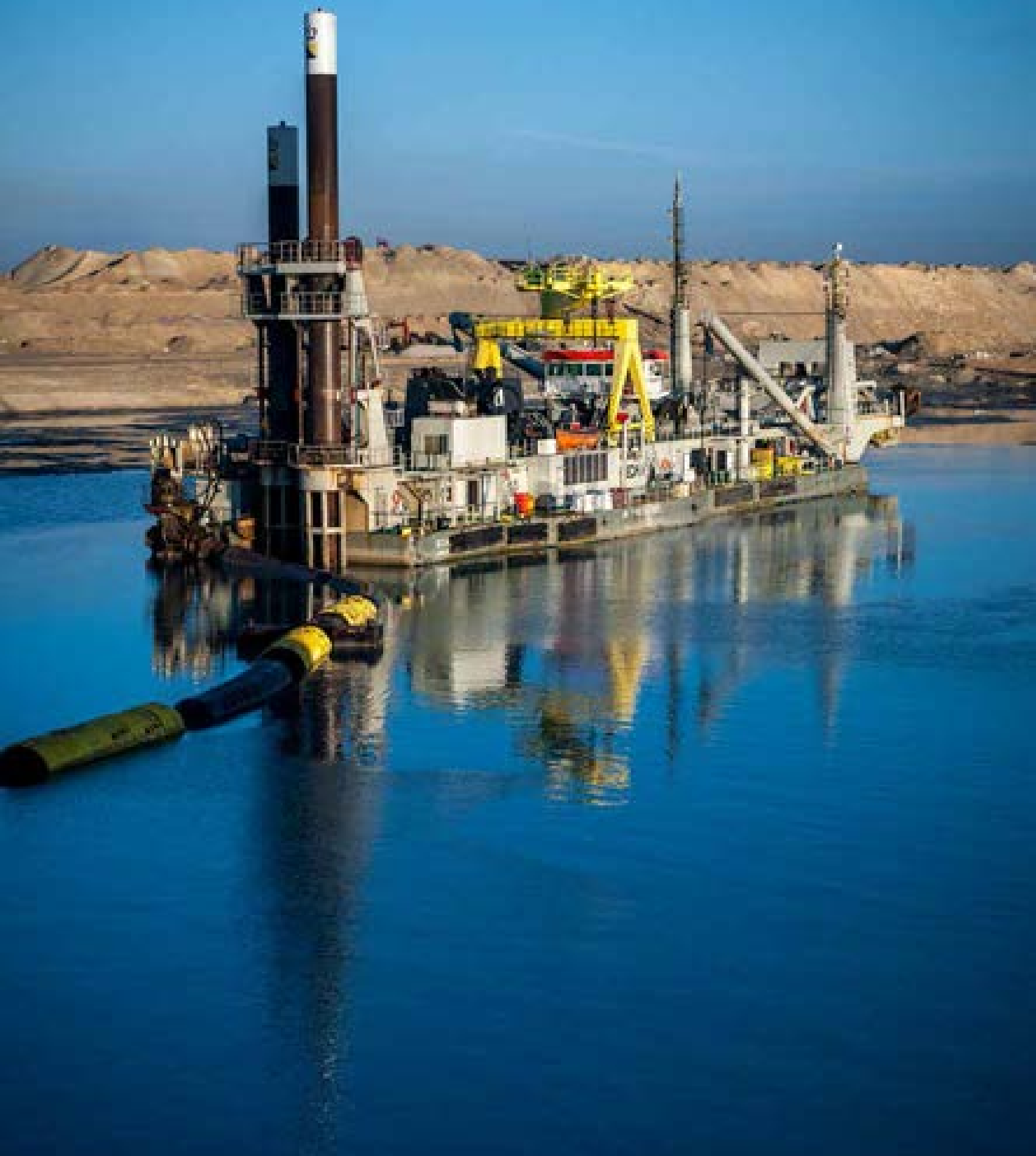
Baggerwerkzaamheden door de snijkopzuiger Edax ten behoeve van de uitbreiding van het Suezkanaal in Egypte.
