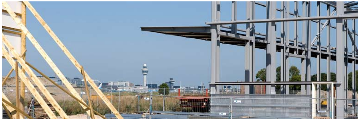
Panalpinagebouw op Schiphol in aanbouw
