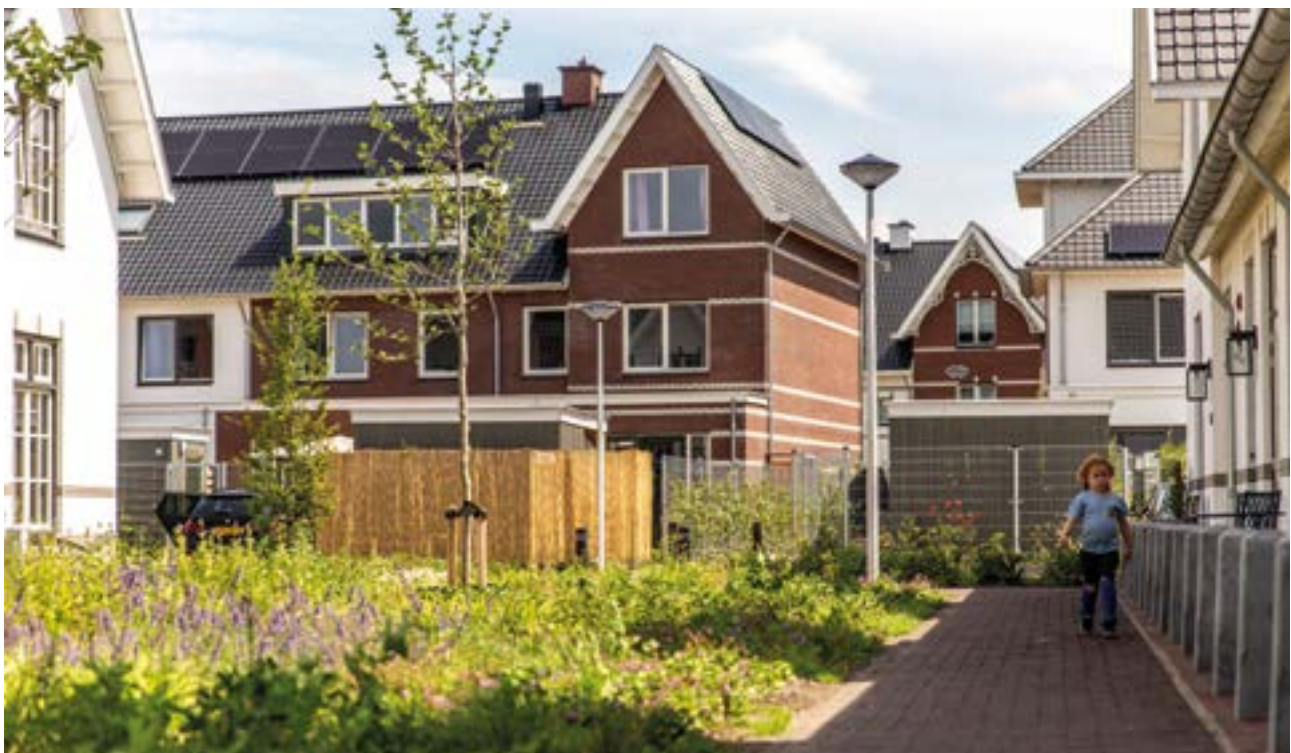
Landscronerhof, Weesp (the Netherlands) - BAM Bouw en Vastgoed Nederland
