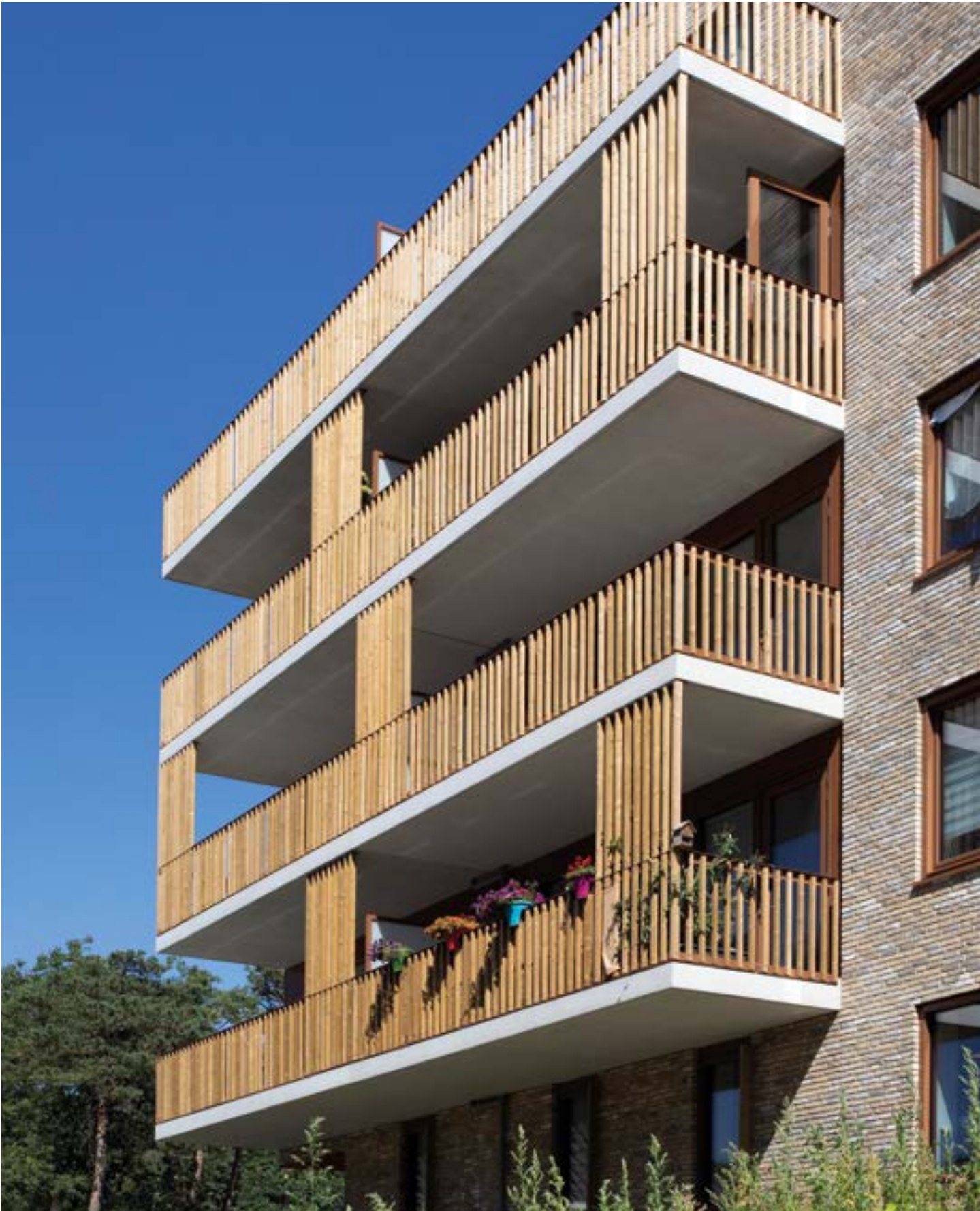
Kerckebos, Zeist (The Netherlands) - BAM Bouw en Vastgoed
