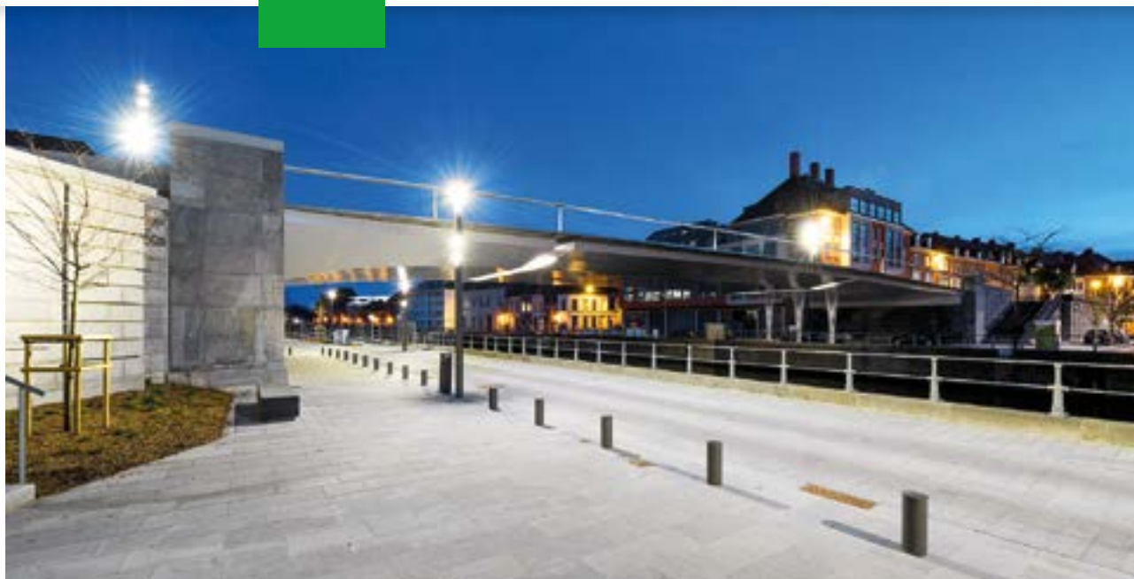
Pont-à-Ponts, Tournai (Belgium) - BAM Galère
